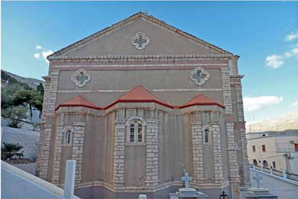
Εικ. 10. Η ανατολική εξωτερική πλευρά του ναού. Φωτογραφία Μιχαήλ Κουτελλάς.
